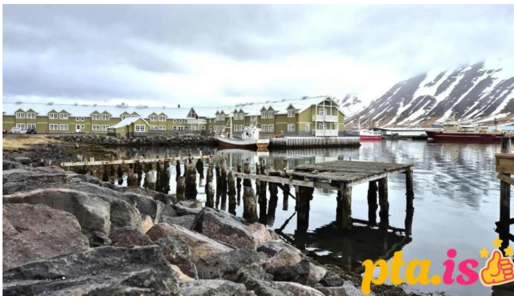
Siglufjörður byggingarverktaki íbuðarhúsnæðis
