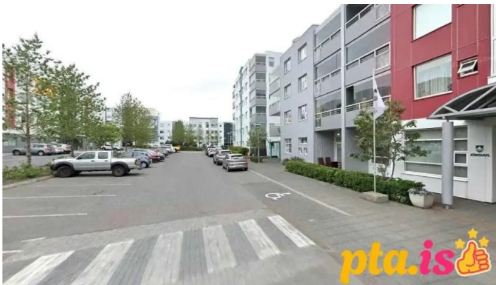
Jonshus felagsmiðstoð garðabær
