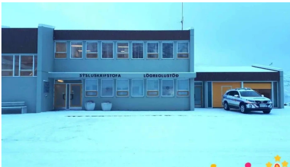
Logreglan a eskifirði eskifjörður
