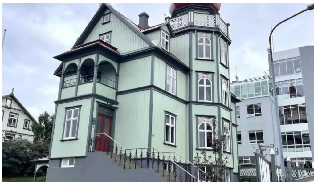
Landshofdingjahusid naepan sogulegt kennileiti
